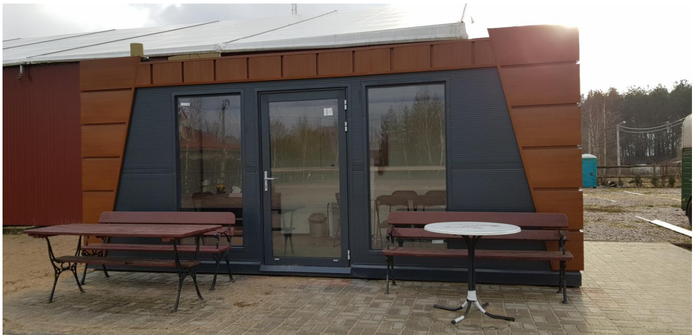
Kryta ujeżdżalnia jeździecka oraz ogrzewana poczekalnia
